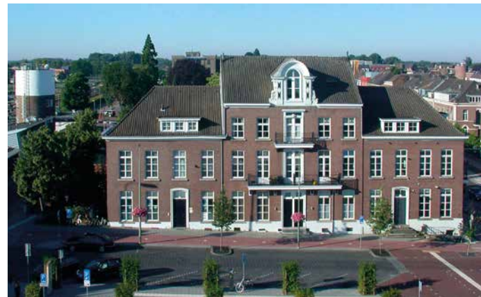
In 1944 bewoonde de familie Drogen het pand links (nr. 7), met als burens Verhoeven (nr. 6), Spinhof (nr. 5) en Kentgens (nr. 4). Uiterst links is de oude watertoren te zien naast het spoorwegemplacement.
